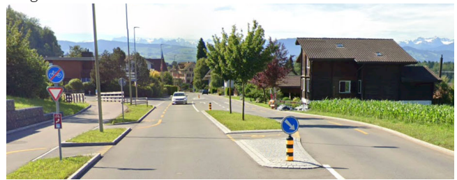
Umgesetzte Einfahrbremse Albisstrasse
