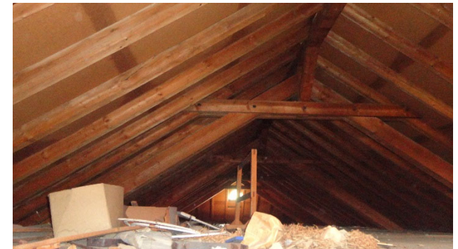
Dachstuhl Turnhalle; Dämmebene liegt zwischen Dachstuhl und Turnhalle
