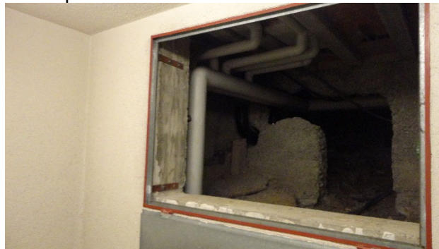
Revisionsöffnung zu Hohlraum unter Bodenplatte
